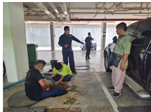
รูปที่ 9 การสูบน้ำเกรอะ บ่อตกไขมัน
