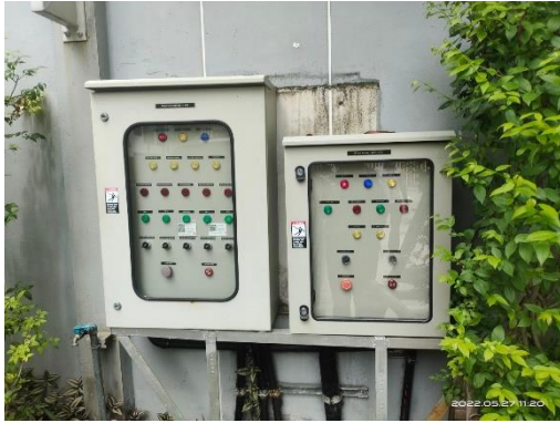
รูปที่ 30 ตู้ควบคุมระบบบำบัดน้ำเสีย
