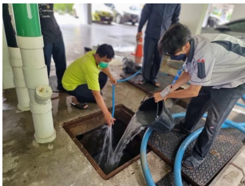
รูปที่ 9 การสูบน้ำเกรอะ บ่อตกไขมัน
